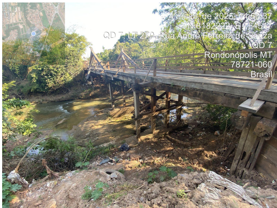
Imagem 6 - Local de substituição da ponte de madeira por OAE - vista da estrutura da ponte existente na seção do curso d'água.
